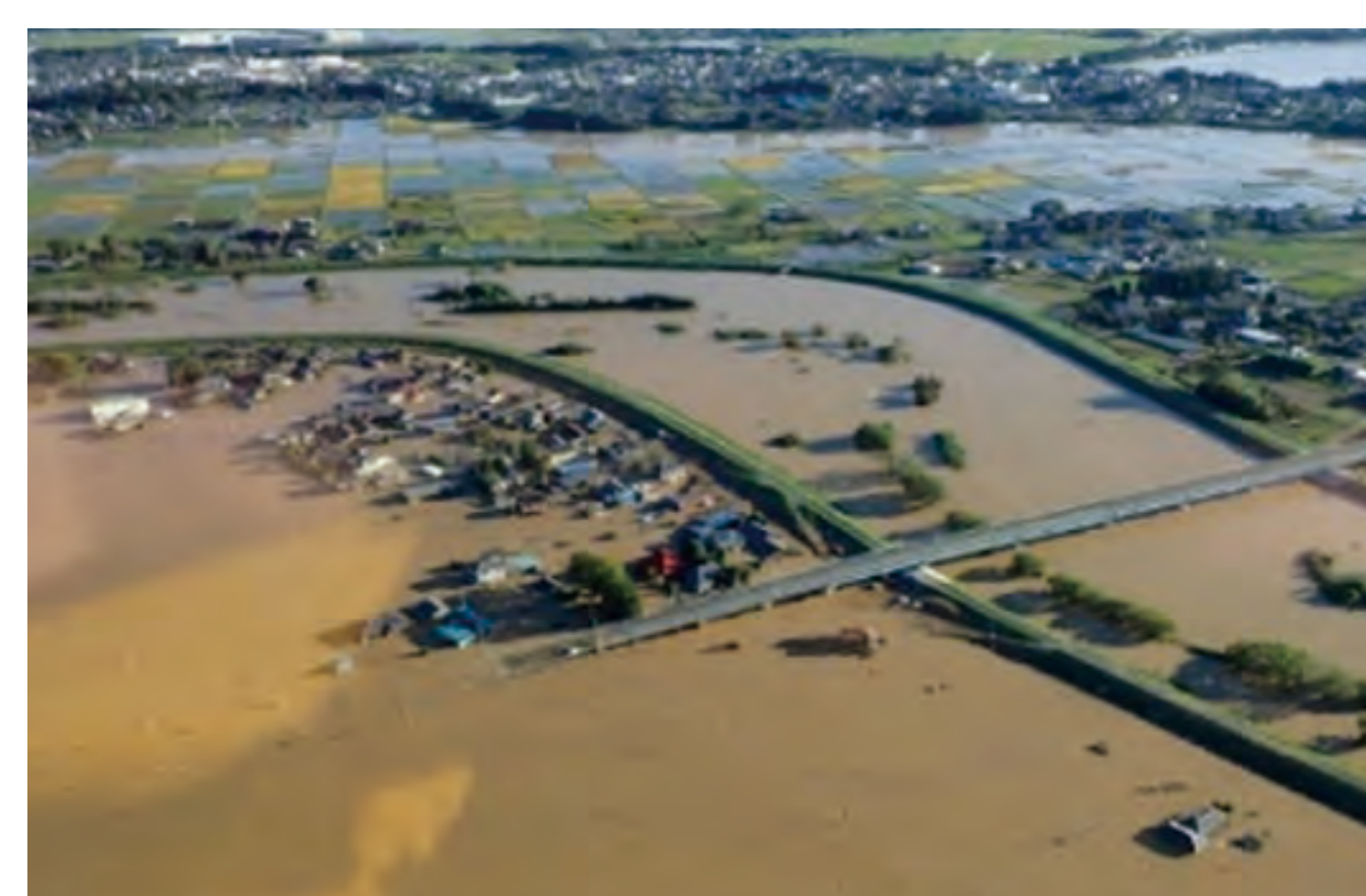
令和元年東日本台風で 河川が氾濫(東松山市)
